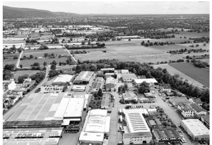
Blick auf das Industriegebiet in Dossenheim. (Foto: Landratsamt Rhein-Neckar-Kreis)
